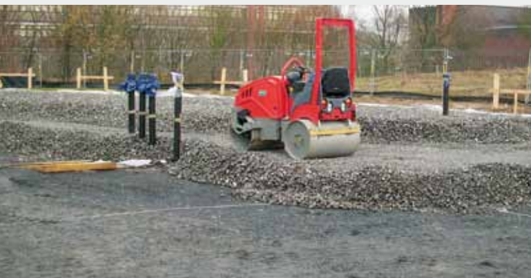
ZABUDOVÁNÍ VE DVOU VRSTVÁCH: od tloušťky vrstvy 40 cm
