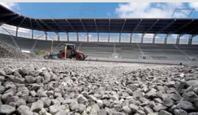
AFG FOTBALOVÁ ARÉNA ST. GALLEN, ŠVÝCARSKO GEOCELL® použitý jako lehký drenážní a tepelně izolační podsyp pod fotbalovým trávníkem
