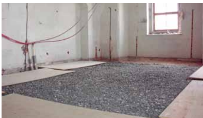
NOVÁ KONSTRUKCE PODLAHY ve staré zástavbě
