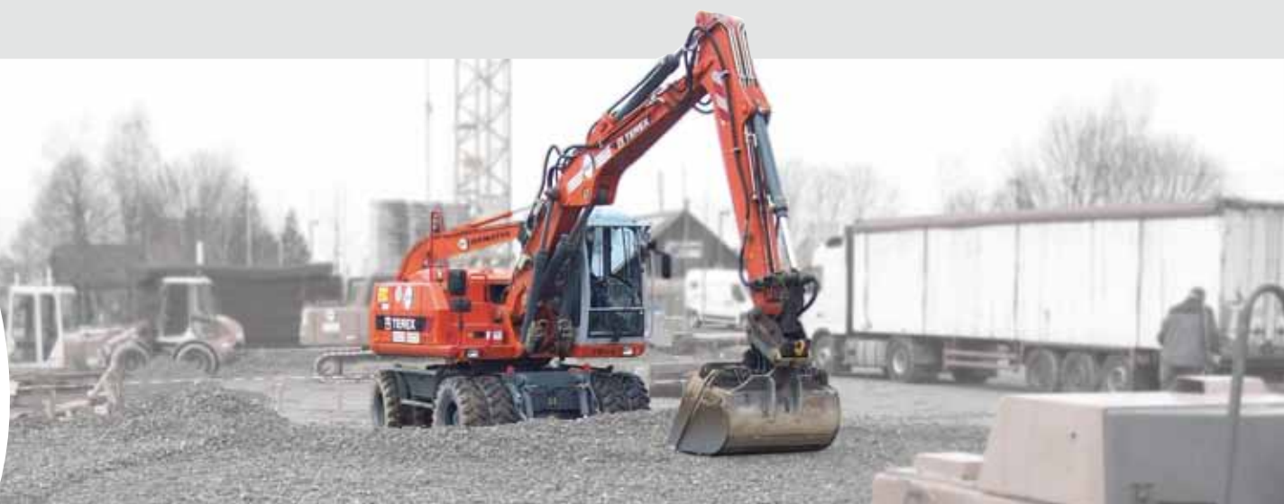
Velkoplošné zabudování materiálu GEOCELL® pro výrobní halu
