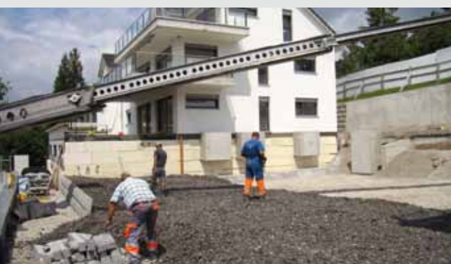
ZAJIŠTĚNÍ SVAHU JAKO VYZTUŽENÁ ZEMINA V kombinaci se sklopěným granulátem GEOCELL®, výška konstrukce 2,80 m
