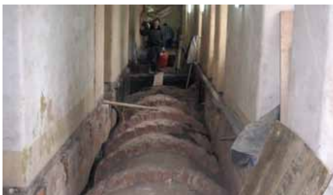
LEHKÉ A ODOLNÉ PROTI VHLKOSTI: GEOCELL® snižuje zatížení starých klenutí
