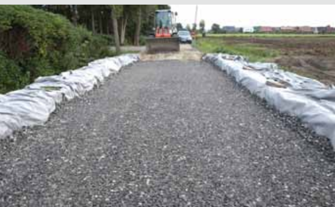
STAVBA SILNICE, EDEWECHT, NĚMECKO: Příjezdová cesta k zemědělskému objektu na půdě se špatnou únosností
