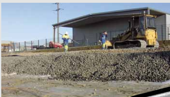
STABILIZACE PARKOVACÍ PLOCHY vícevrstvá vestavba ze sklopěného granulátu GEOCELL® jako zatížení rozdělující vrstva (1,80 m)
