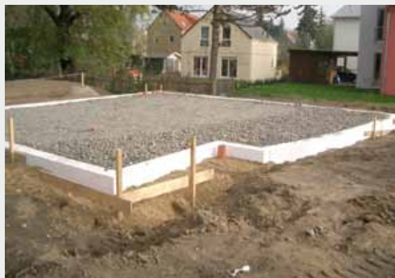
RYCHLEJI TO NEJDE: Sklopěnový granulát GEOCELL® jako únosná tepelná izolace pod základovou desku šetří čas výstavby.
