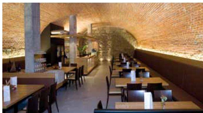
IZOLACE PODLAHY A KLENBY: Staré oblouky jsou odlehčeny a izolovány
