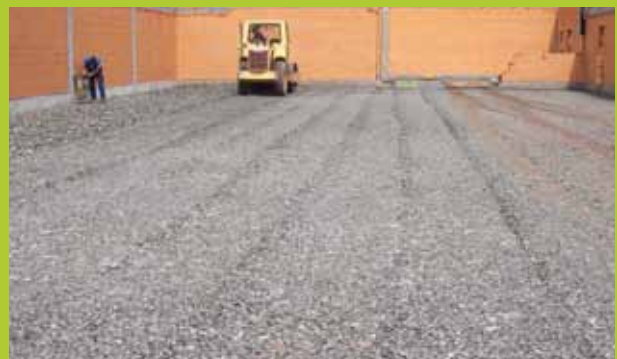
PŘERUŠUJÍCÍ VZLÍNAVOST: Nahrazuje vrstvu přerušující vzlínávost
