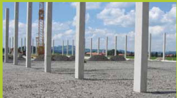
ŠETŘÍCÍ ČAS A NÁKLADY: zvláště u velkoplošného zpracování
